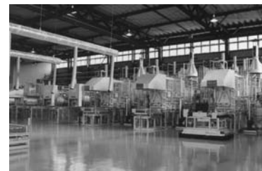
熱処理設備全自動ライン (AGV・自動倉庫採用)
